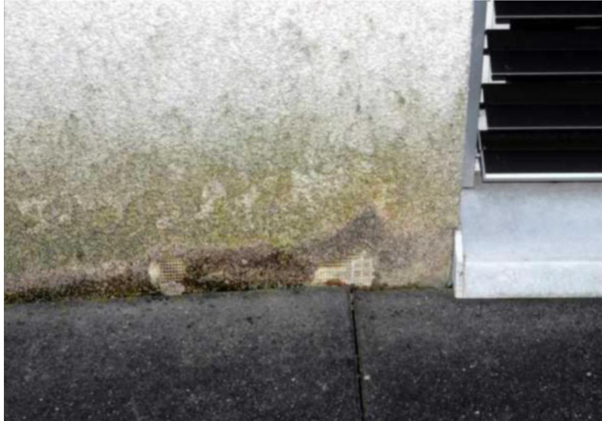
**Partenza non impermeabilizzata, infiltrazioni di umidità**
