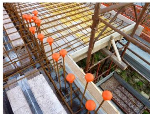
2. Stato avanzamento lavori per la realizzazione dei terrazzi (coibentati con pannelli in poliuretano) e dei cordoli in c.a. (coibentati con pannelli in fibra di legno)
