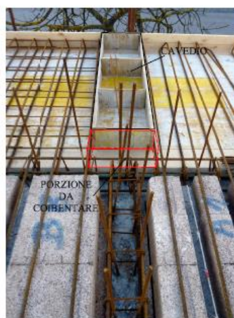
5. Dettaglio della cassatura e della coibentazione in corrispondenza del cavedio sul fronte tergale dell'edificio
