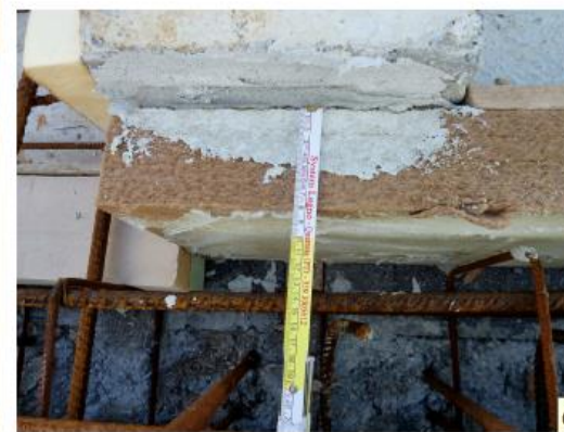
7. Verifica dello spessore del pannello coibente in fibra di legno (sp.=8 cm)
