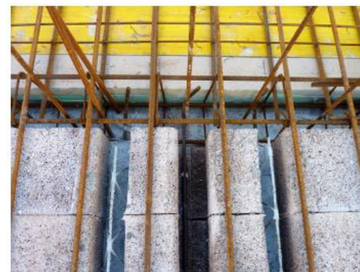
3. Stato avanzamento lavori per la realizzazione dei terrazzi: all'interno della soletta sono stati posizionati pannelli coibenti in xps e poliuretano.
